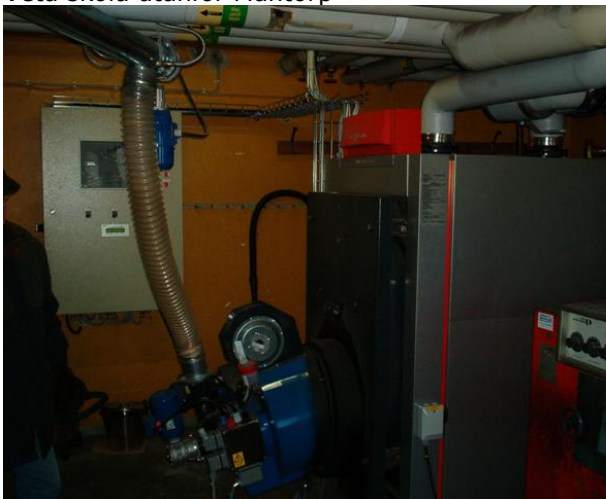
Skolans nya pelletspanna en Viessmann Vitoplex 100 – på 300 kW's effekt
