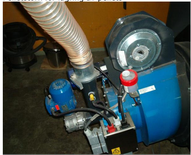
Här kommer pelletsen i lagom takt för jämn och optimal förbränning.
